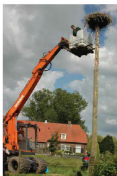
14-6-2014. Soms is een paal te gevaarlijk om een ladder tegenaan te zetten, in dit geval hadden de sprekers de paal omgevoerd tot een gatenkaas. Dit nest was dringend aan vervanging toe.
